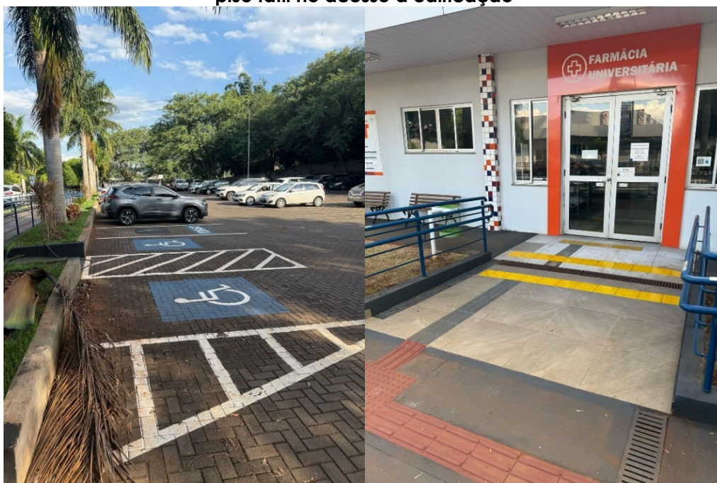
Figura 7 – Estacionamento sem rota de pedestres e ausência de padronização na implantação de piso tátil no acesso à edificação
