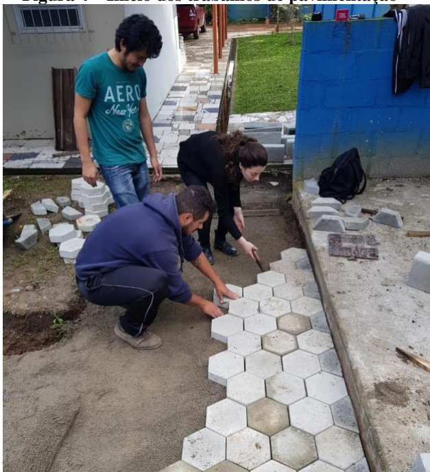
Figura 4 – Início dos trabalhos de pavimentação
