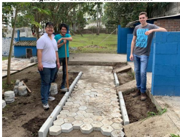
Figura 5 – Trabalho em andamento
