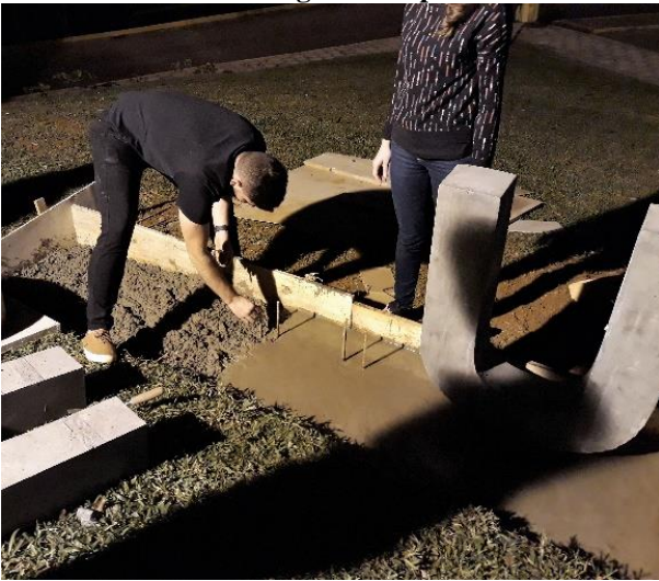
Figura 12 – Inserção das esperas de aço durante a concretagem da sapata
