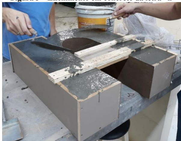
Figura 3 – Enchimento em concreto da letra “n”
