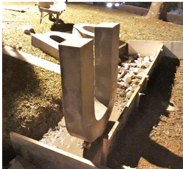
Figura 11 – Enchimento da sapata com corpos de prova e concreto
