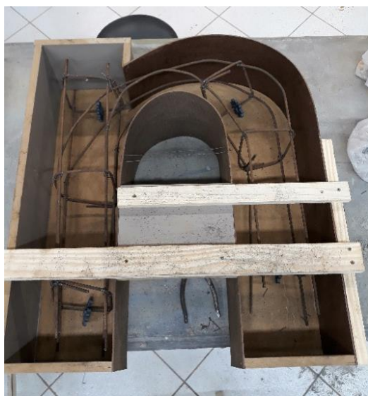
Figura 2 – Fôrma e armadura da letra “n”
