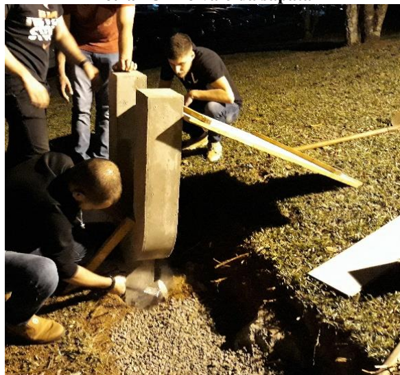
Figura 10 – Encaixe da fundação e escoramento da letra “U” no valo da sapata
