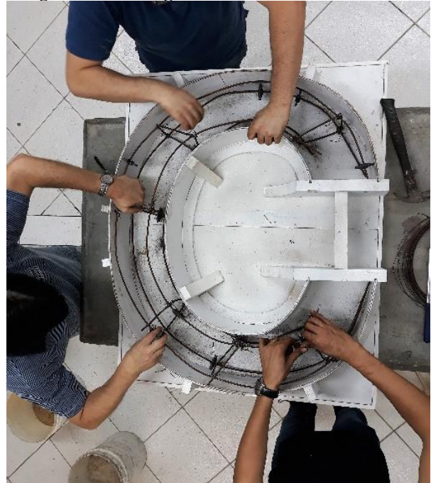
Figura 5 – Montagem da armadura da letra “C”
